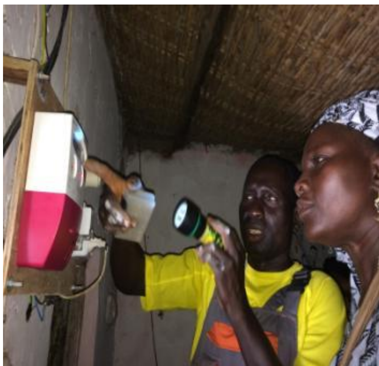
Exemple : technicien local explique à l'usager le fonctionnement du « Electricity Dispenser » - compteur intelligent-
